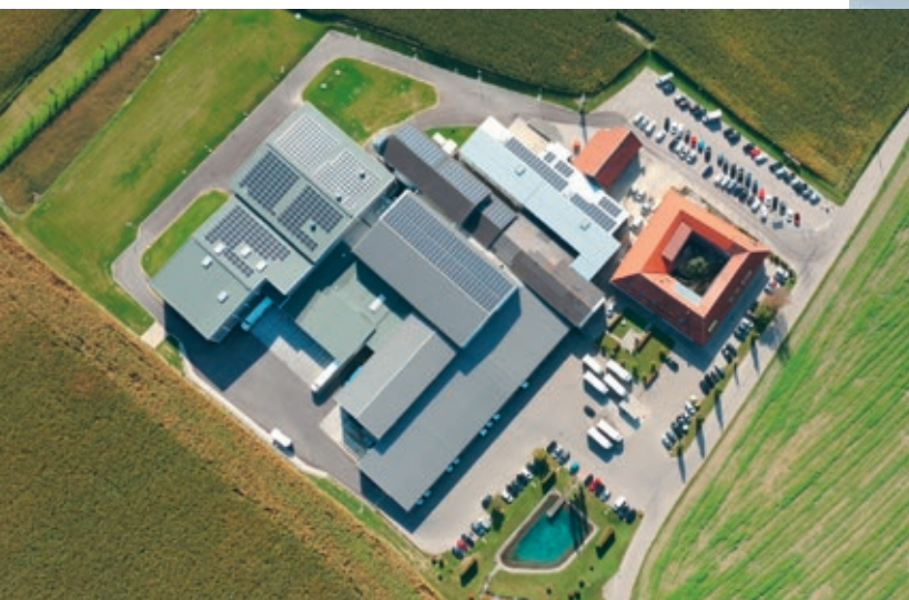
Der Klaus Hof in Grieskirchen wandelte sich vom traditionellen Vierkanthof zu Logistikzentrum, Unternehmenszentrale und Eventlocation.
